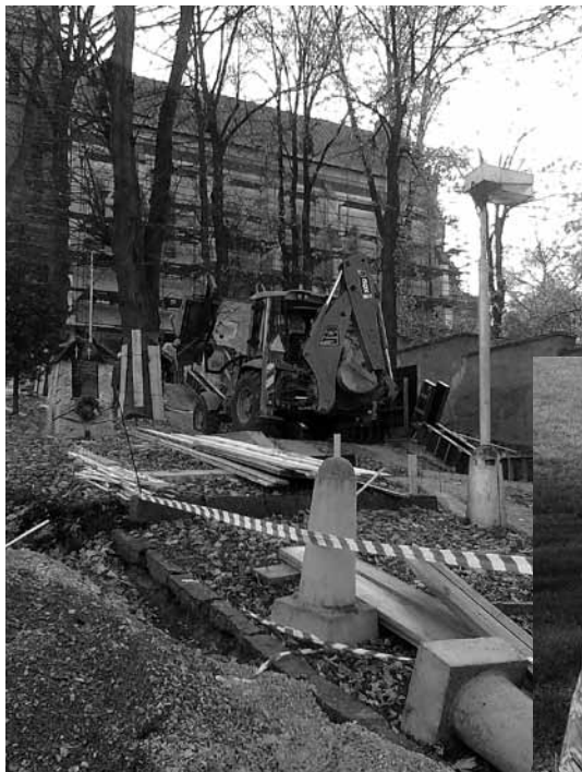
Rekonstrukce schodů ke kostelu sv. Mikuláše
