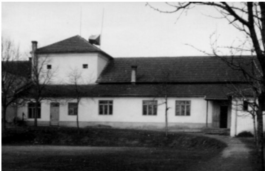
Sokolovna po postavení r. 1927.
