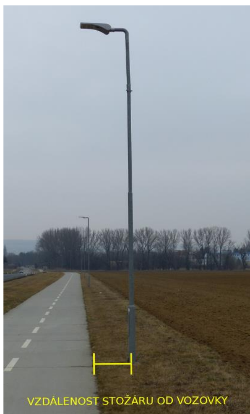
Obr. 1: Určování rozměrů světelného bodu – výška svítidla a výška sloupu
