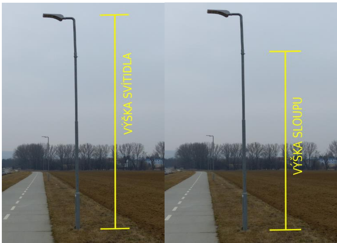
Obr. 1: Určování rozměrů světelného bodu – výška svítidla a výška sloupu
