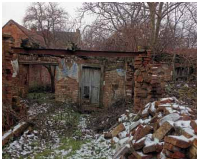
Dům č. 12 současný stav
