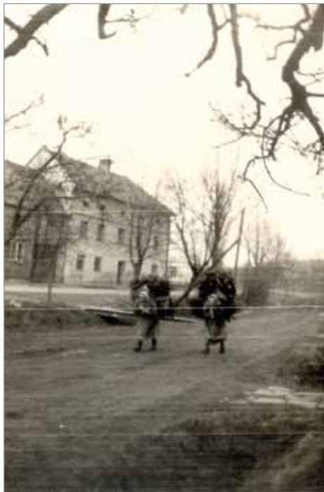
Dům č. 24, četnická stanice
