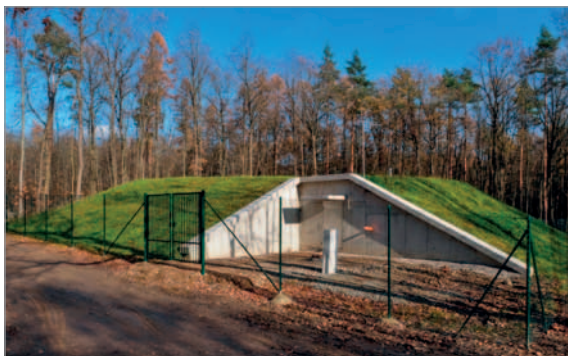
Vodojem Pozoříce III
