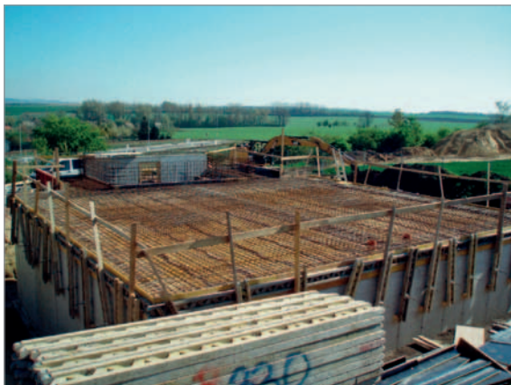
Armování stropu vodojemu Prace
