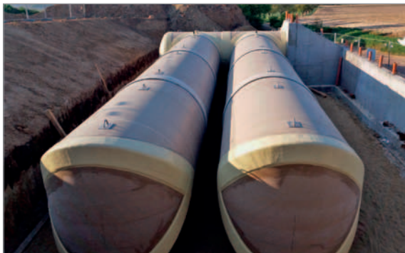
Dvoukomorový sklolaminátový vodojem DN 3000 v Tvarožně
