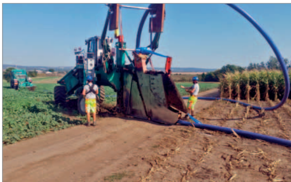
Pluhování potrubí PE DN 150
