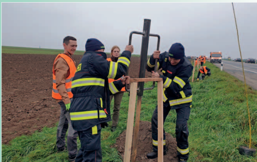
Výsadba stromů u krajské silnice u obce, 4. listopadu 2022
