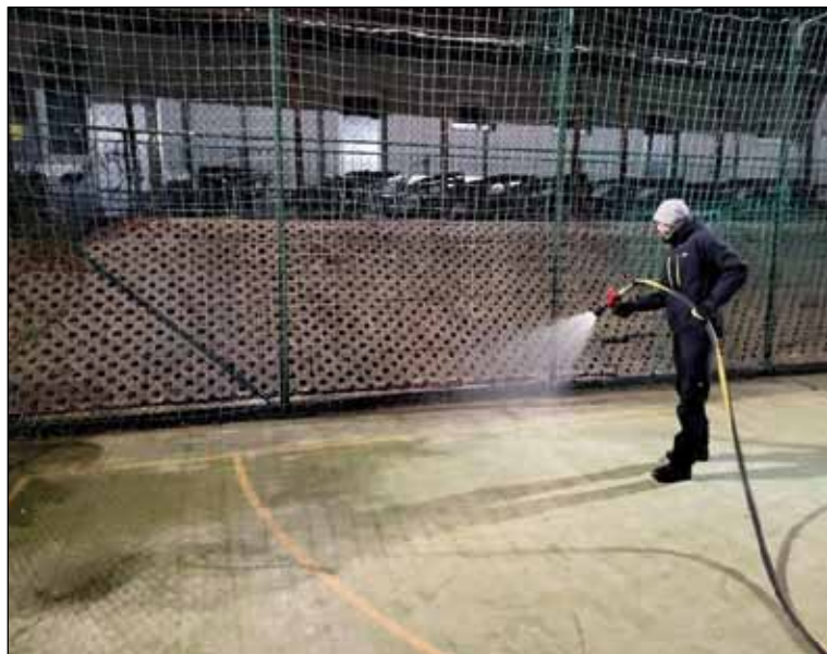
Nástřik první vrstvy – zacelení pórů umělého povrchu.
