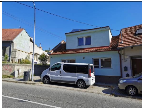
Příliš mohutný vikýř, navíc s nevhodným opačným směrem sklonu střechy
